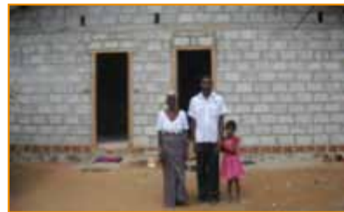
Bouw van huisje 9 in Bogahayaya, opening op 16/09/2013
