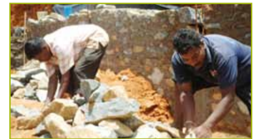
Rotsblokken uitzoeken om de muur te metselen
